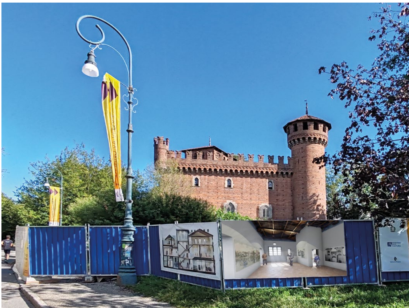
Fig. 2 – Il cantiere di restauro che sta coinvolgendo il Borgo dagli inizi del 2024. In particolare, transenne intorno alla Rocca, con l'illustrazione dei render di progetto (a sinistra, la sezione prospettica dei fabbricati attorno al Cortile di Avigliana mentre, a destra, una vista prospettica della Casa di Pinerolo).
