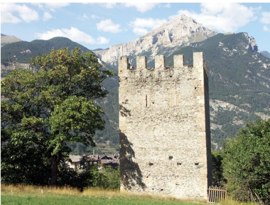
Fig. 1 – La Torre delfinale di Oulx prima del restauro.
