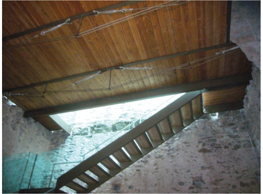
Fig. 2 - Torre del finale di Oulx: il primo orizzontamento in legno, sostenuto dalle travi Fink.
