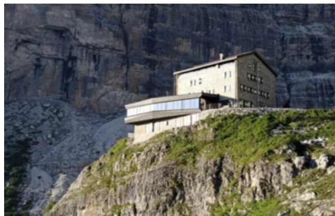
Figura 4. Ristrutturazione e ampliamento del rifugio Maria e Alberto ai Brentei, ALPstudio, 2022.
