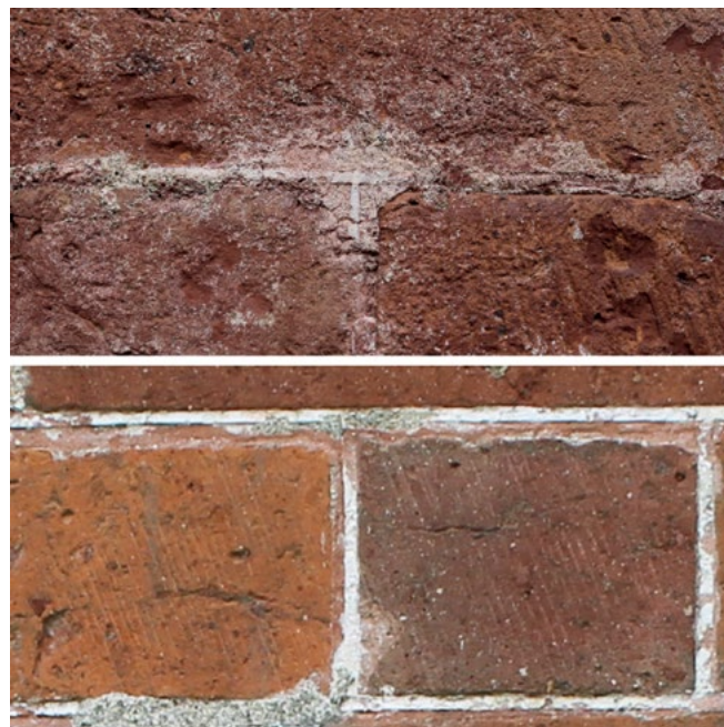
Figura 9. Rifugatura dei giunti malta.
