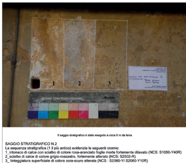
Figura 4. Campione di analisi stratigrafica eseguito su di un fronte dell'Area Campione (ditta Primat), da Piano di manutenzione. Schede analisi stratigrafica.
