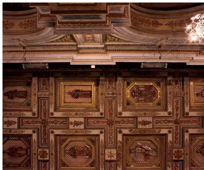
Figura 2. Soffitto ligneo a lacunari della basilica.
