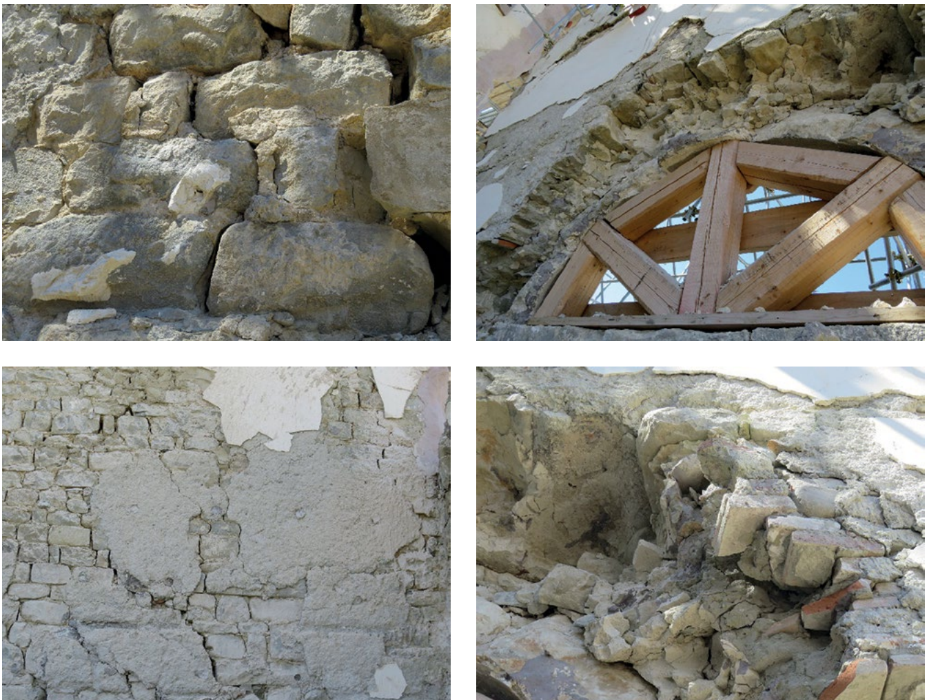
Figura 20. Diversi particolari dei punti di iniezioni cementizie rilevabili sulle superfici e all'interno della tessitura muraria.
