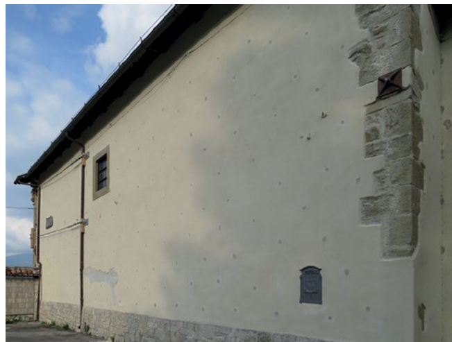
Figura 2. Prospetto nord-ovest della chiesa. Sono visibili i punti delle iniezioni e, sulla destra, il capochiave del nuovo tirante incluso nelle opere di messa in sicurezza per rinforzare l'arco dell'abside.
