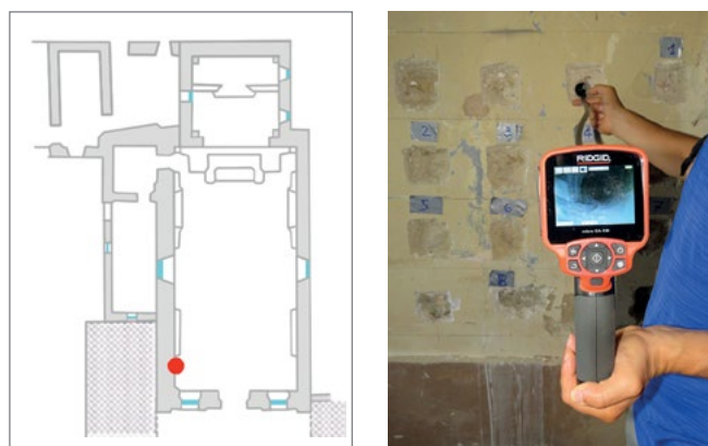
Figura 16. Ubicazione ed esecuzione della prova endoscopica all'interno della forometria esistente.
