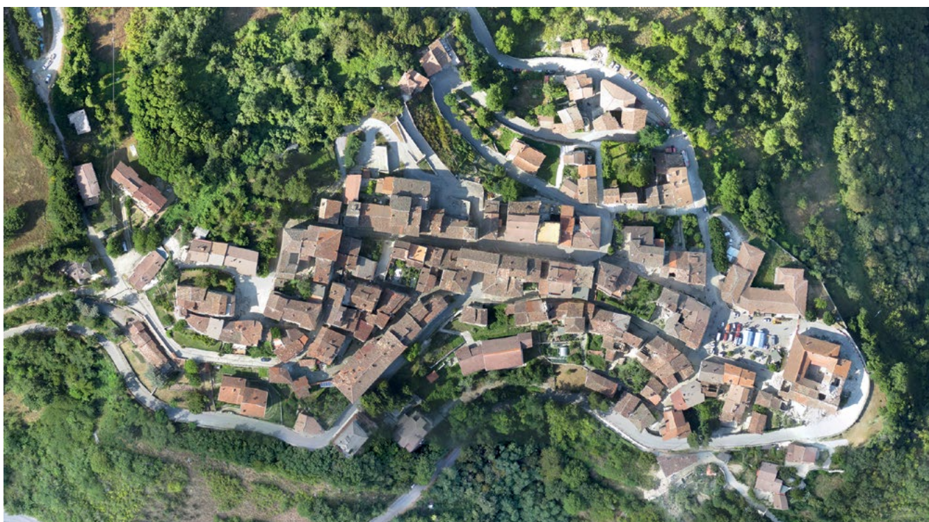
Figura 5. Confronto tra ortofoto di Accumoli, generate nelle diverse fasi dello sciame sismico: (a) 27 agosto 2016, (b) 12 novembre 2016.
