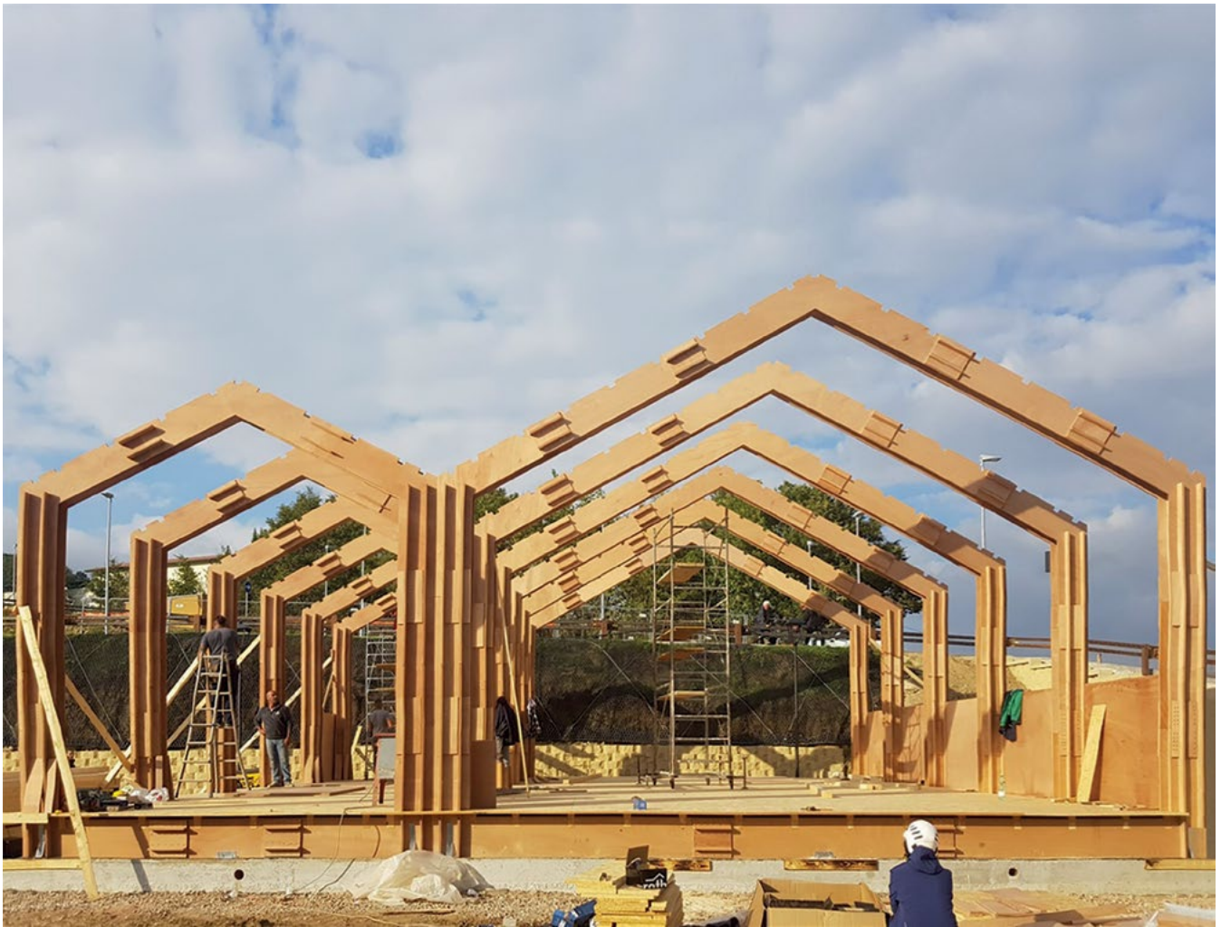
Figura 10. Accupoli. Realizzazione della struttura in compensato.
