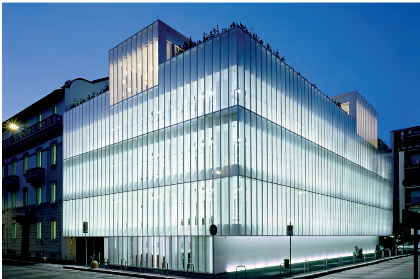
Figura 12. Piuarch, Nuova sede D&G (foto A. Piovano).
