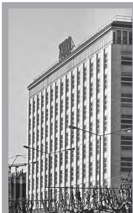
Figura 10. Palazzo per uffici RIV, ora Alleanza Toro Assicurazioni, via Mazzini 53, corso Cairoli. Amedeo Albertini, Ufficio Costruzioni FIAT (Vittorio Bonadè Bottino); 1955-56 (da MONTANARI, 2008).
