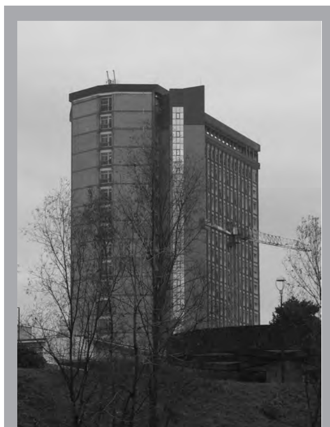
Figura 18. Centro Traumatologico Ortopedico (CTO), Via Zuretti, 29. Servizio Tecnico INAIL (Roma): L. Brusa, Longo; 1959-65 (foto DR).
