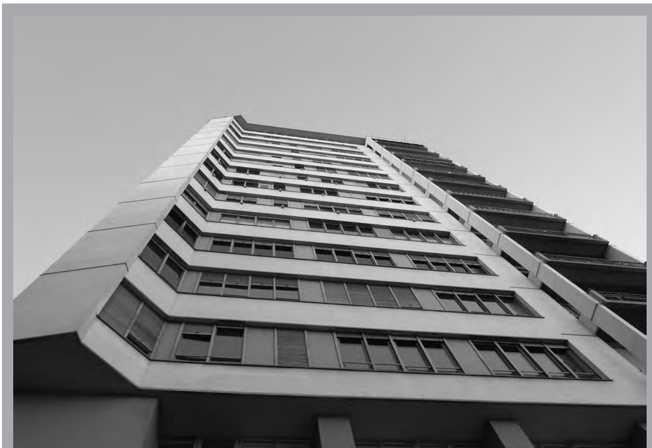
Figura 7. Edificio pluripiano per abitazioni, negozi e uffici, via Pietro Micca 21. Gualtiero Casalegno; 1952 (foto AM).
