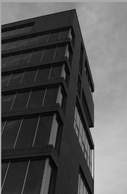
Figura 22. Torre per uffici, piazza Maestri del Lavoro d'Italia, Collegno. Frlan + Jansen Architetti, Carlo Bagnasacco, 1999-2002 (foto DR).
