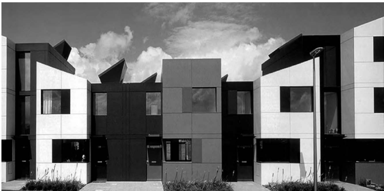
Figura 3a. Eco-residenze nel nuovo quartiere Oxley Woods a Milton Keynes (UK). Vista d'insieme di un'aggregazione dei moduli e fasi di montaggio del modulo abitativo (24h) (Fonte: Pappalettere Silvio).
