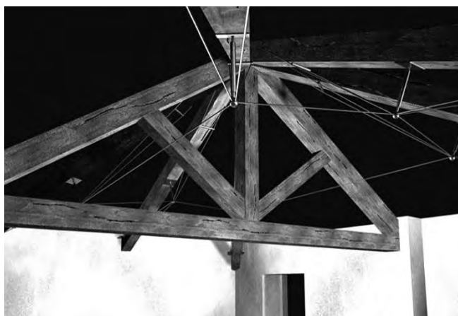
Figura 3. Villa Della Porta Bozzolo, Casalzuigno, Varese: consolidamento della capriata mediante realizzazione di struttura reticolare mista.
