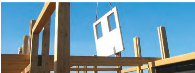
Figura 3. a), b), c). Diverse fasi di montaggio di edifici di 3 piani situati a L'Aquila.
