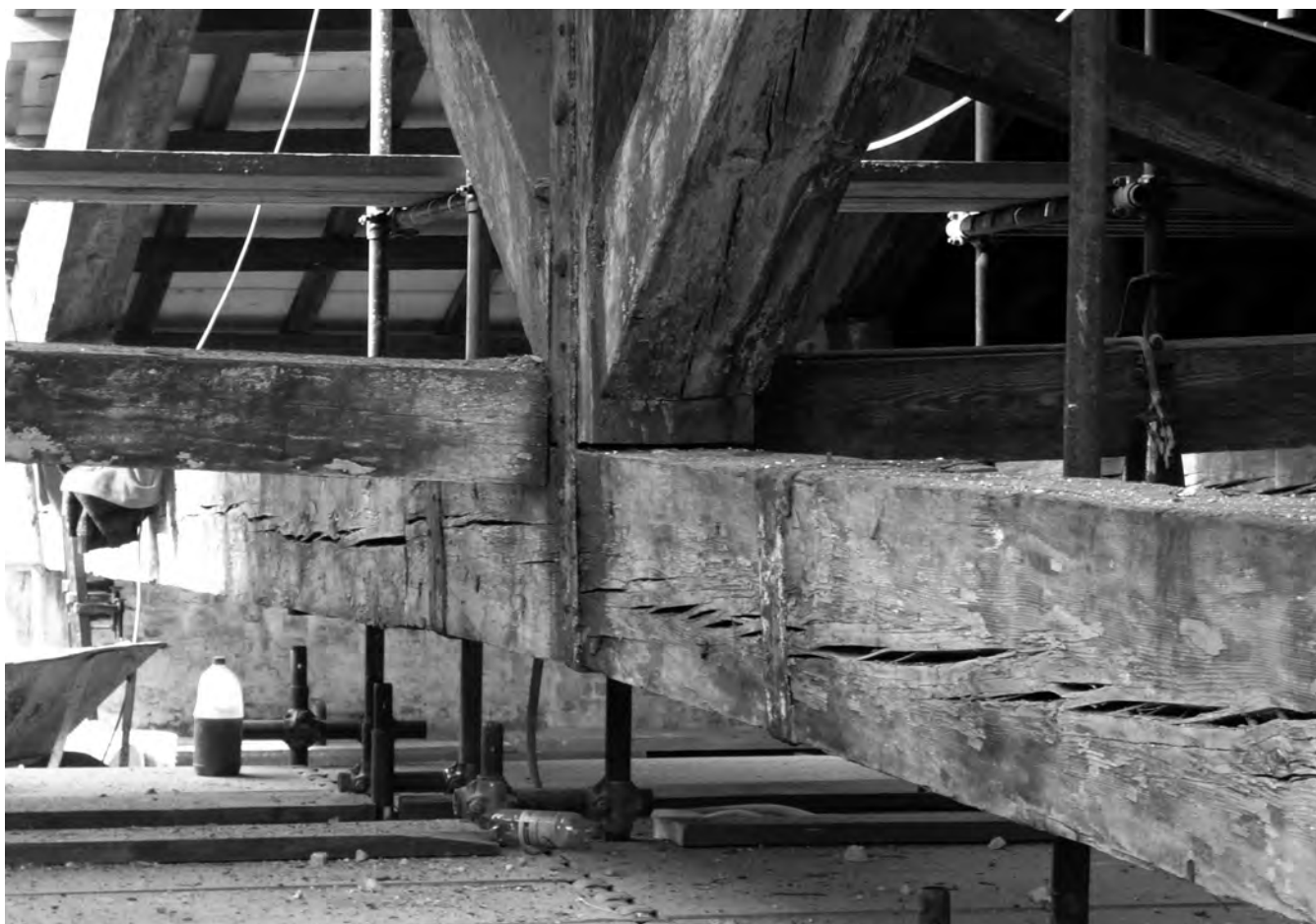
Figura 2. Particolare di una delle capriate trecentesche del tesone dell'Isolotto. Si può notare l'inarcamento della catena, il nodo chiuso monaco-catena e le reggiature a caldo della connessione a dardo di giove della catena (foto impresa Dal Carlo).
