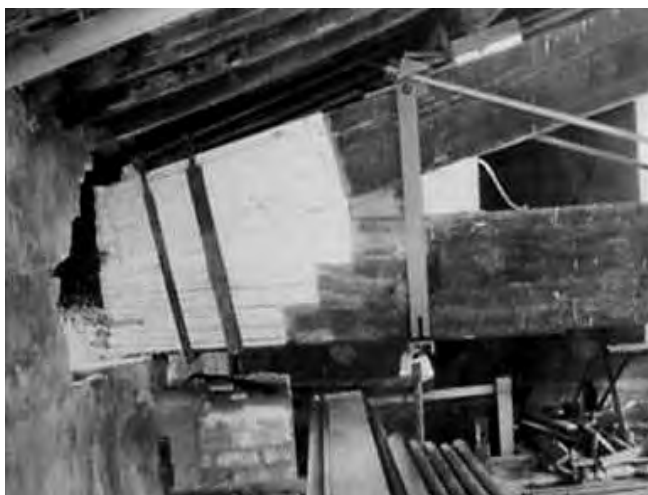
Figura 12. Cerchiatura del nodo di una capriata e barre metalliche inserite nella muratura d'appoggio della capriata per consolidare la parete e diffondere la pressione indotta dalla capriata (Tampone con la collaborazione di Pier Paolo Derinaldis, 2009).
