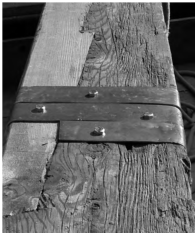
Figura 5. Protesi a dardo di Giove con reggiatura a caldo (foto C. Menichelli).
