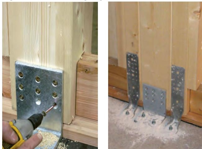
Figure 9c, 9d. Connessioni legno-legno.
