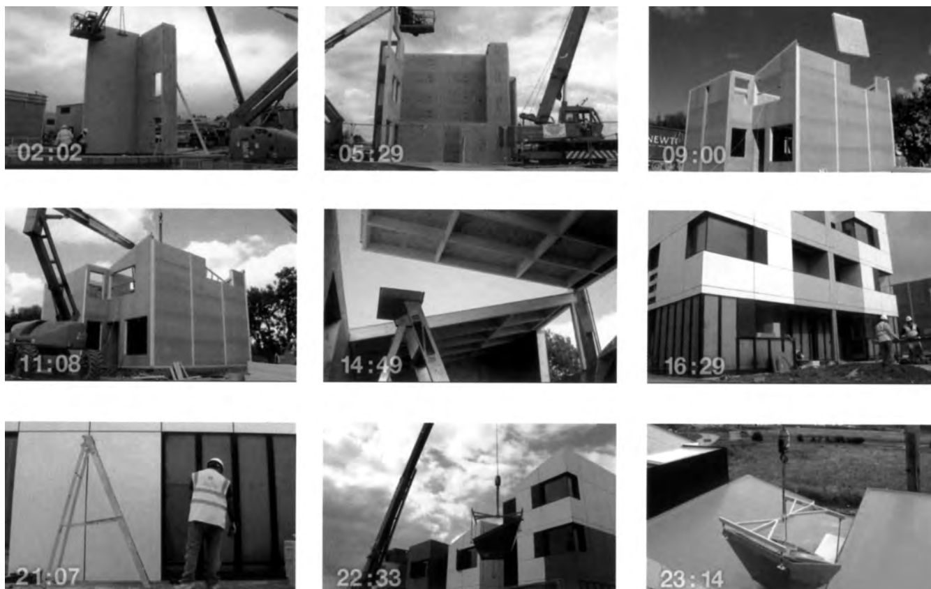
Figura 3b. Eco-residenze nel nuovo quartiere Oxley Woods a Milton Keynes (UK). Vista d'insieme di un'aggregazione dei moduli e fasi di montaggio del modulo abitativo (24h) (Fonte: Pappalettere Silvio).
