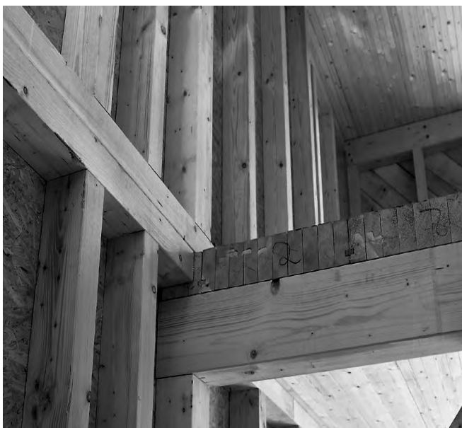
Figura 3. Solaio a tavole impilate.
