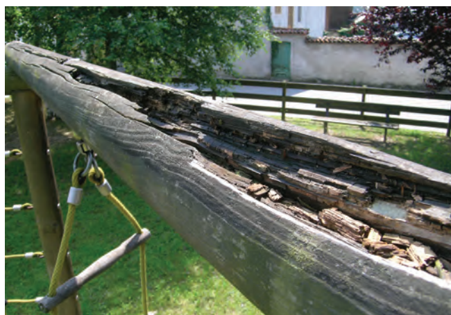
Figura 5. Parco giochi nel comune di Cerrione (BI): elemento costruttivo di conifera.
