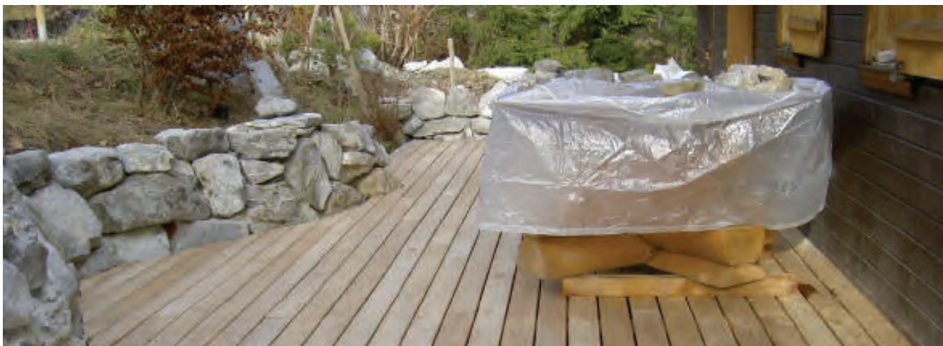
Figura 9. Pavimentazione esterna in legno di robinia. Tratto da: www.acasolv.ch
