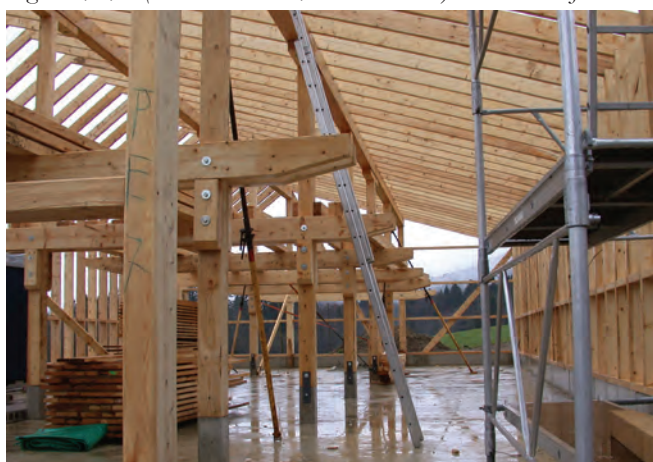
Figure 2, 3, 4 (dall'alto in basso, in senso orario). Stalla nello Jura: cantiere.
