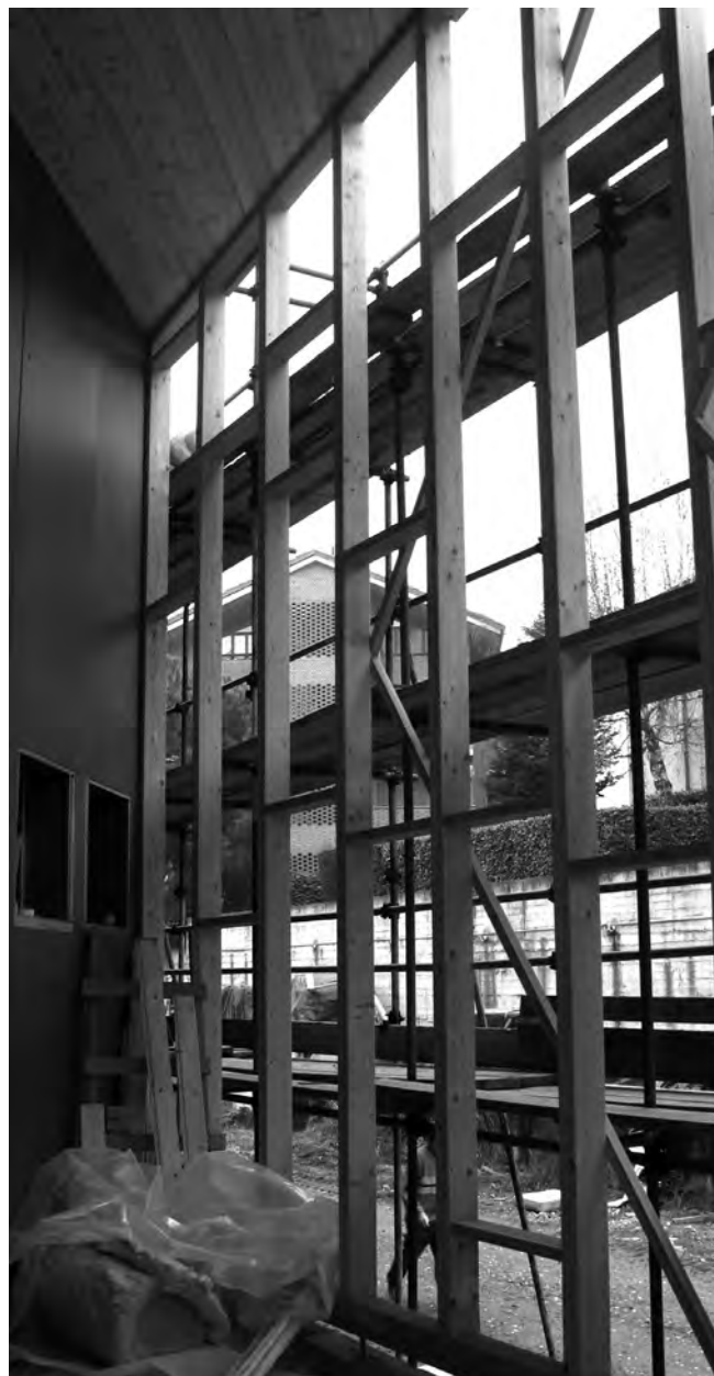
Figura 10. Particolare della "piazza coperta" all'ingresso della scuola materna.
