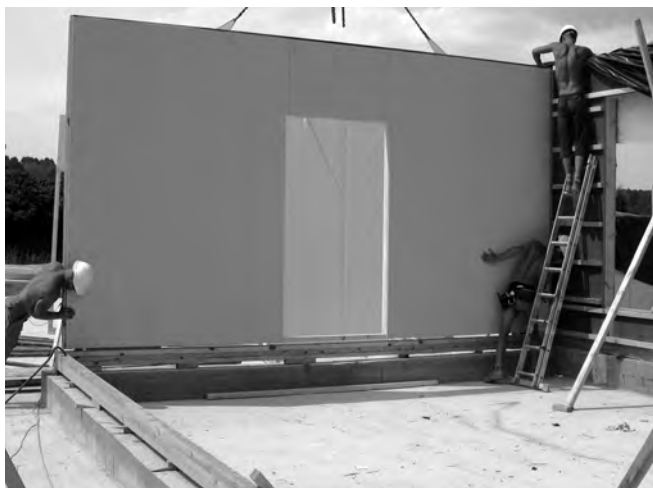
Figure 6. Il montaggio di una parete, realizzata con un sistema costruttivo a telaio formato da montanti 4,5x14,5 riempito con isolante e controventato su entrambi i lati da pannelli strutturali in legno (Durelis).
