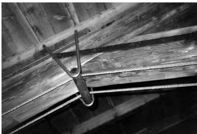
Figure 2b, 2c. Casa Ex Masciadri, Arcene, Bergamo: dettagli del consolidamento con utilizzo di un cavo sagomato post-tesato, in posizione intradosale, per consolidare i puntoni a sbalzo, fortemente inflessi.
