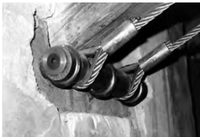
Figure 2b, 2c. Casa Ex Masciadri, Arcene, Bergamo: dettagli del consolidamento con utilizzo di un cavo sagomato post-tesato, in posizione intradosale, per consolidare i puntoni a sbalzo, fortemente inflessi.
