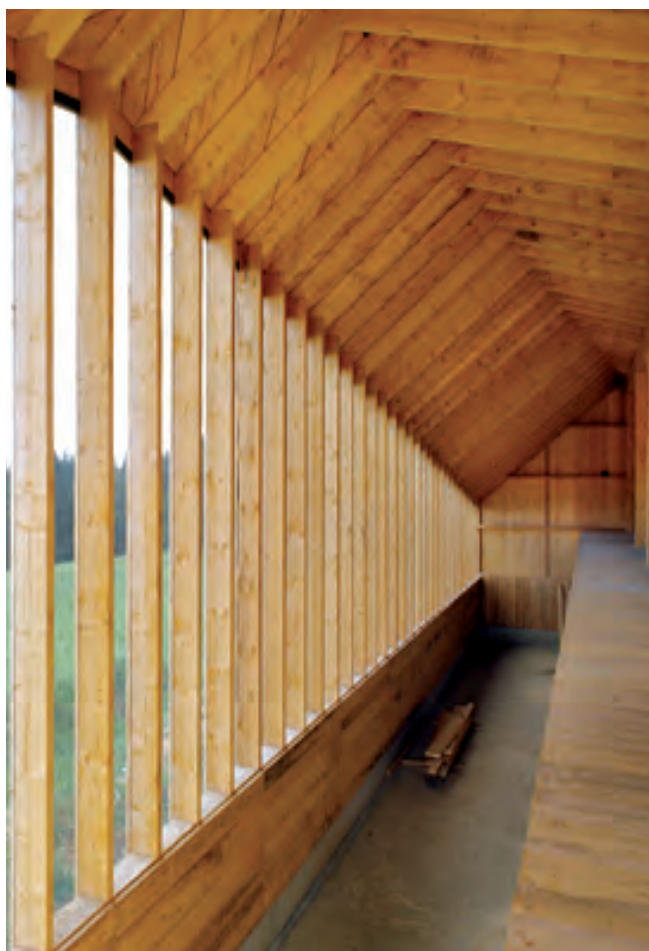
Figure 6. Stalla nello Jura: interni.
