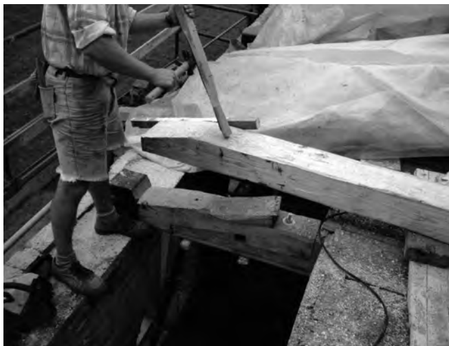
Figura 3. Posa in opera del puntone di una capriata dopo aver sostituito l'estremità deteriorata della catena.
