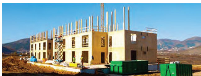
Figura 3. d), e), f). Edifici completi - Progetto C.A.S.E. (Foto ILLE Prefabbricati S.p.A.).
