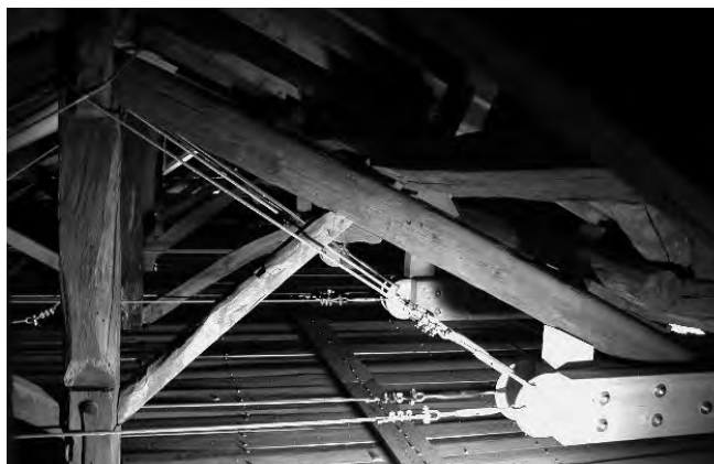
Figura 7. Ex monastero di S. Clara, Pavia: consolidamento mediante cavi esterni post tesi e "bilancini" in legno lamellare appoggiati sulla muratura.
