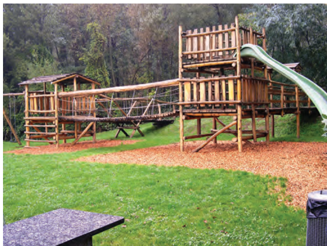
Figura 11. Parco giochi realizzato in legno di castagno. Tratto da: www.acasolv.ch .
