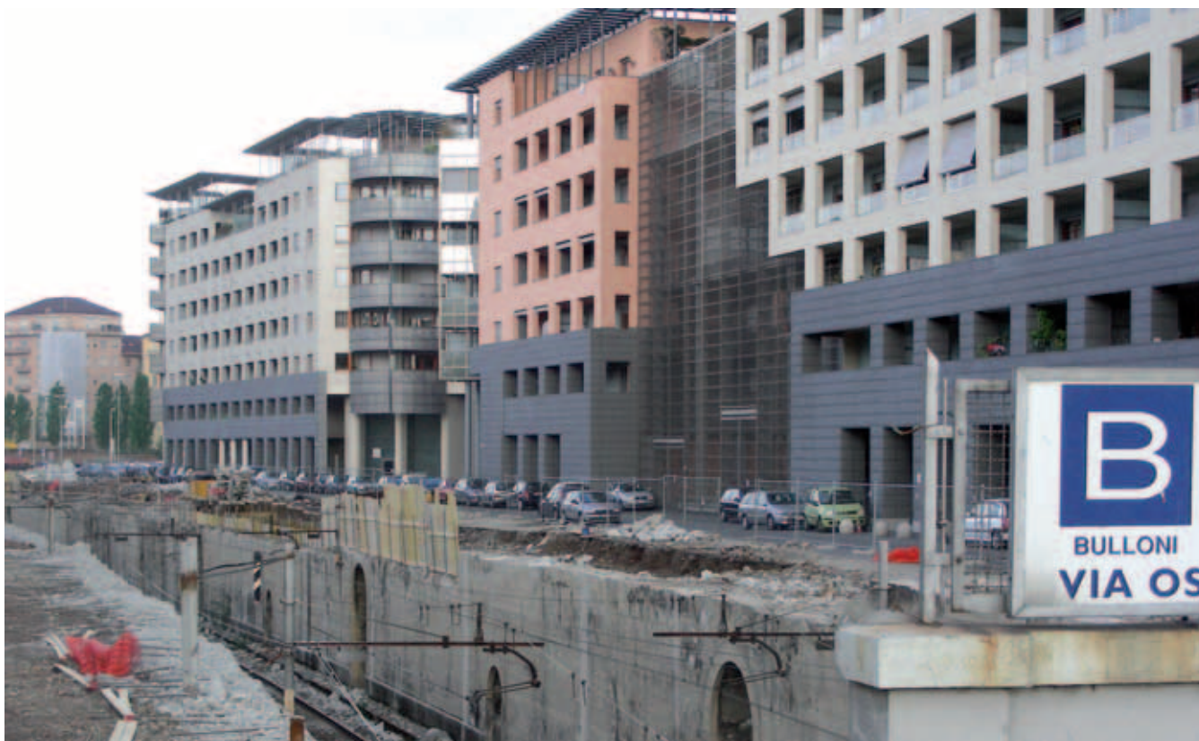
Figura 4. Spina 1: le nuove residenze e i lavori per la copertura del Passante Ferroviario. Figure 4. Spina 1: The new residences and works for the coverage of the Railway Underpass.
