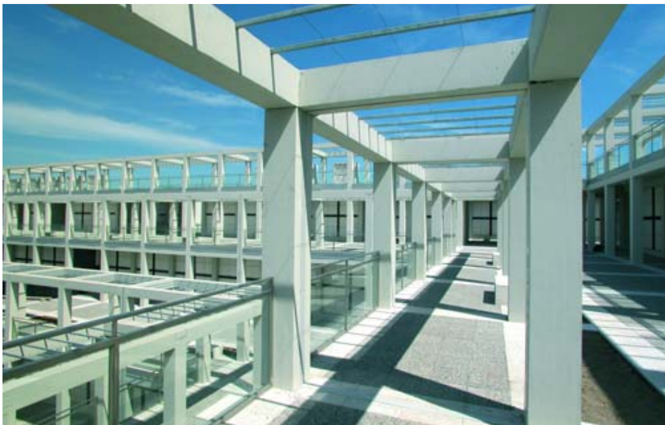
Figure 7, 8. I pergolati in realizzazione.
