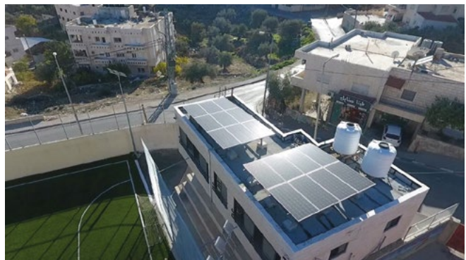
Figura 3. Impianto fotovoltaico presso il campo sportivo Davide Astori.
