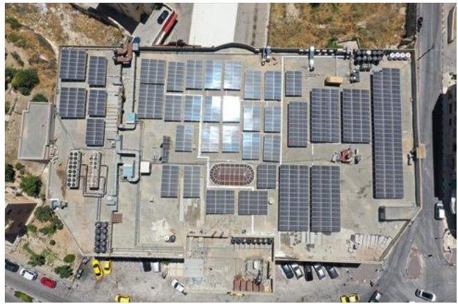
Figura 2. Pannelli solari sul tetto della stazione centrale dei bus.
