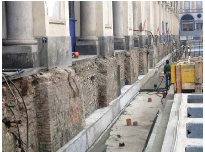
Torino, Piazza San Carlo, sottomurazioni dei pilastri settecenteschi di consolidamento del portico sud riapparso nello scavo del parcheggio interrato (2003).
