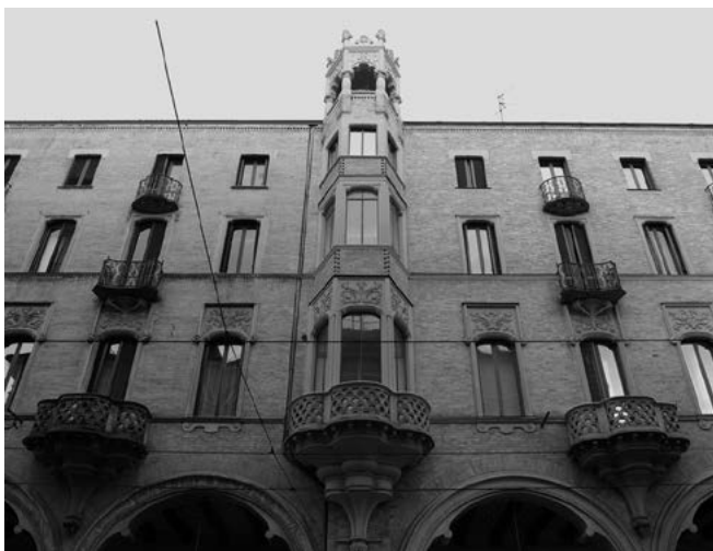
Scorcio di Via Pietro Micca con dettaglio delle facciate di Carlo Ceppi. Dettaglio dei bovindi e dei balconi trilobati (foto B. Biamino 2016).
