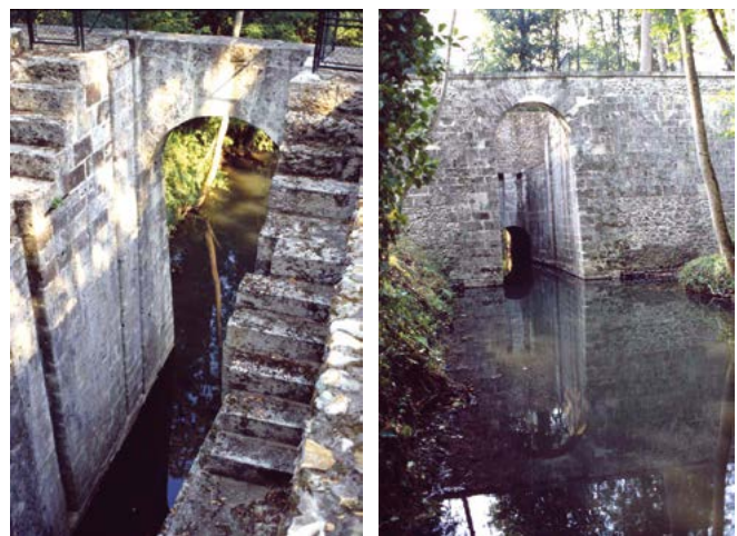
Figura 5. Digue de Boisard, retenue d'eau pour l'alimentation du canal de l'Eure (photos de l'auteur).
