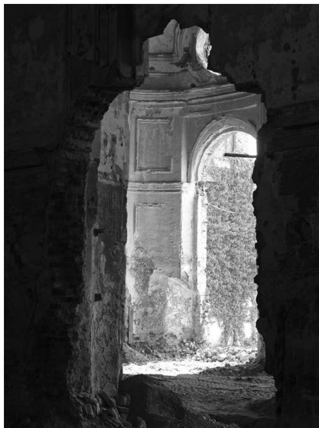
Citroniera Juarriana, Archivio fotografico Struttura di Monitoraggio scientifico dei cantieri di restauro della Reggia di Venaria, CD 42, 18 Marzo 2004, foto di Silvia Beltramo.
