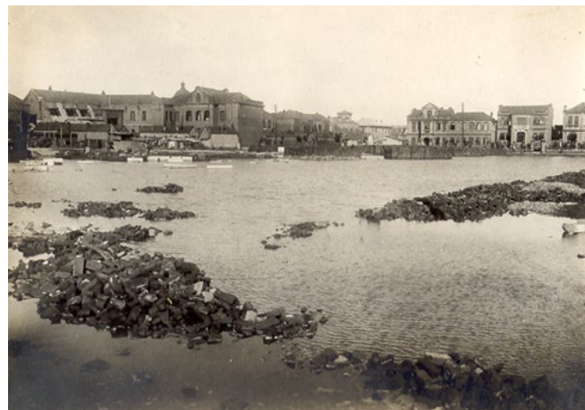
Area del cantiere dell'ospedale della Concessione Italiana a Tianjin, lavori di bonifica. Fonte: archivio fotografico di G. L. Arnaud.
