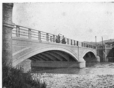
PONTE SULLA DORA RIPARIA IN TORINO (Due arcate di m. 20,50 di luce e m. 2,00 di freccia) Larghezza del ponte: m. 14,20.
