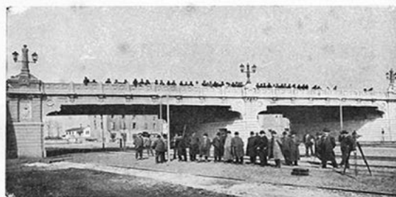
CAVALCAVIA DELLA STAZIONE FERROVIARIA DI PADOVA (Travate di m. 19,35 di luce).
