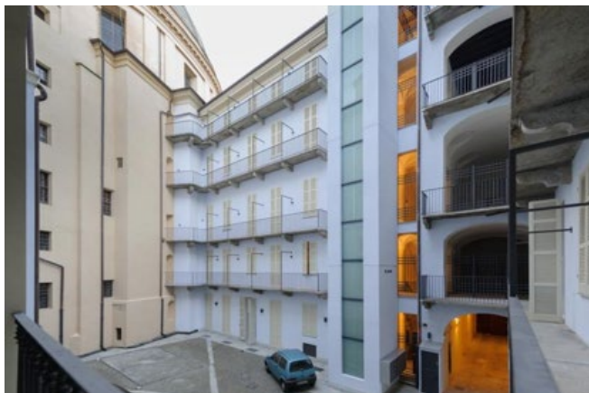
Figura 5. Facciata principale e cortile dello stabile di “Vivo al Venti” a Torino.
