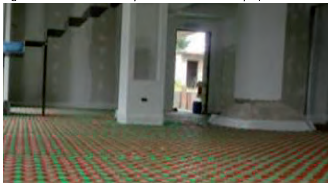
Figura 7. Pannelli radianti a pavimento con isolante preformato.
