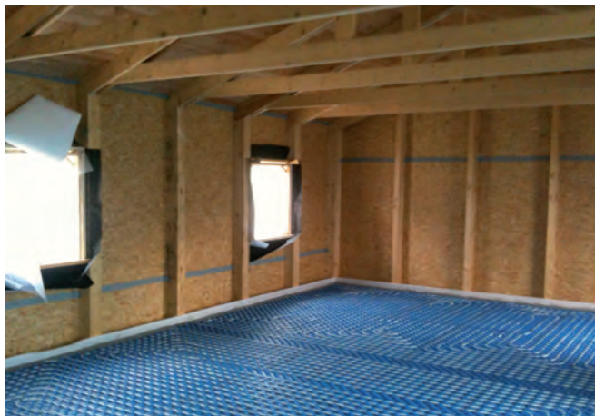
Figura 10. Le serpentine sottopavimento.
