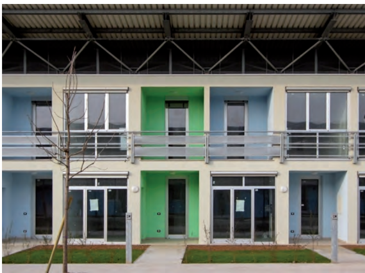
Figura 5. Finito fronte sud 1; progetto B.I.R.D., Brescia: il fronte sud caratterizzato dalle superfici vetrate per la captazione solare (fonte: AIACE Srl). Figura 6. Finito fronte sud 2; progetto B.I.R.D., Brescia: le superfici vetrate sono protette, in estate, da un tetto ventilato aggettante (fonte: AIACE Srl).
