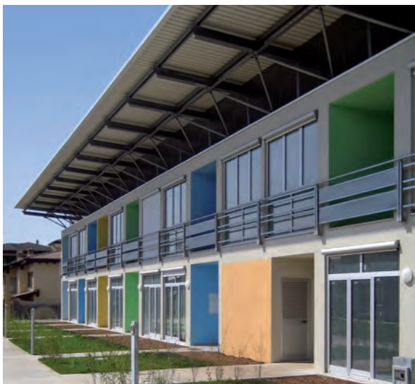
Figura 5. Finito fronte sud 1; progetto B.I.R.D., Brescia: il fronte sud caratterizzato dalle superfici vetrate per la captazione solare (fonte: AIACE Srl). Figura 6. Finito fronte sud 2; progetto B.I.R.D., Brescia: le superfici vetrate sono protette, in estate, da un tetto ventilato aggettante (fonte: AIACE Srl).
