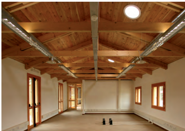
Figura 11. L'impianto di ventilazione.
