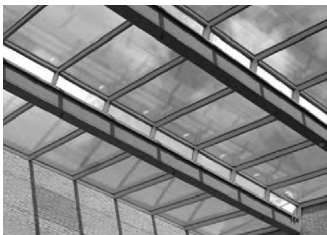
Figura 8. Lucernario fotovoltaico trasparente: le scatole di derivazione e i cavi sono nascosti dentro la struttura di supporto (Onyx Solar).
