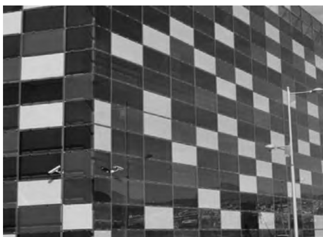
Figura 10. Facciata ventilata fotovoltaica (Onyx Solar).
