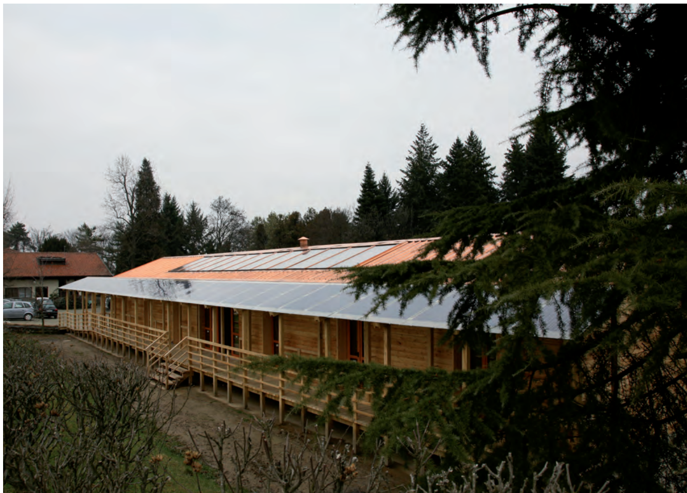
Figura 12. I collettori solari termici e fotovoltaici.
