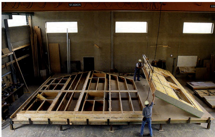
Figura 4. Parete prefabbricata: la costruzione S/R consente la prefabbricazione su misura di intere porzioni di edificio (fonte: Trusjoist).
