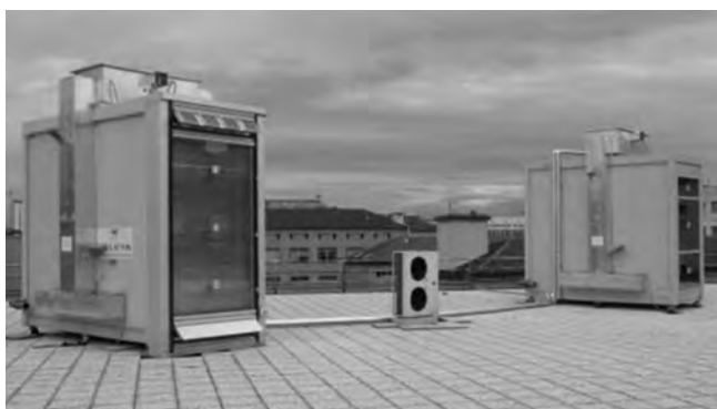
Figura 9. Facciata doppia pelle, a ventilazione ibrida, sulla cella di prova TWINS del Dipartimento di Energetica, Politecnico di Torino.
